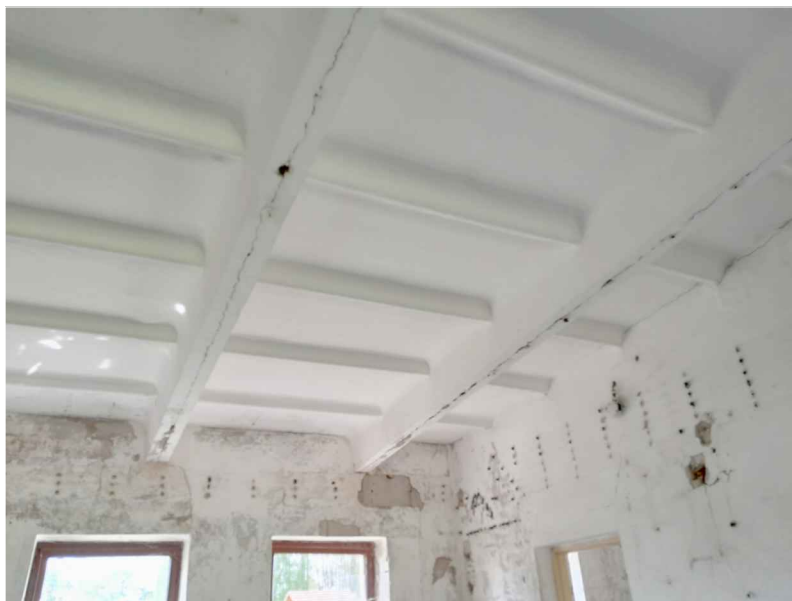
elementy konstrukcyjne stropodachu
