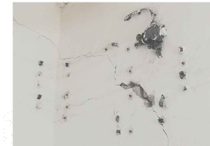
pozostałości po instalacjach
