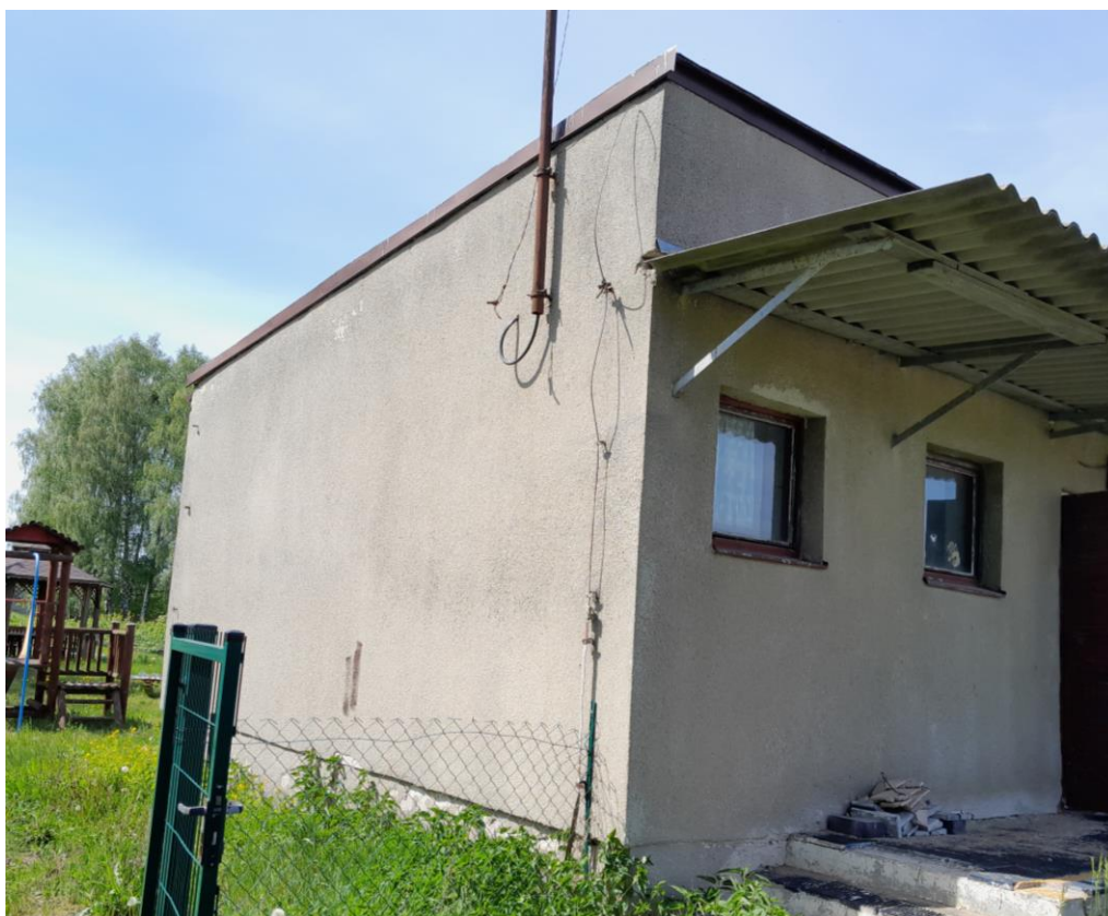
Fot. 4 Elewacja południowa
