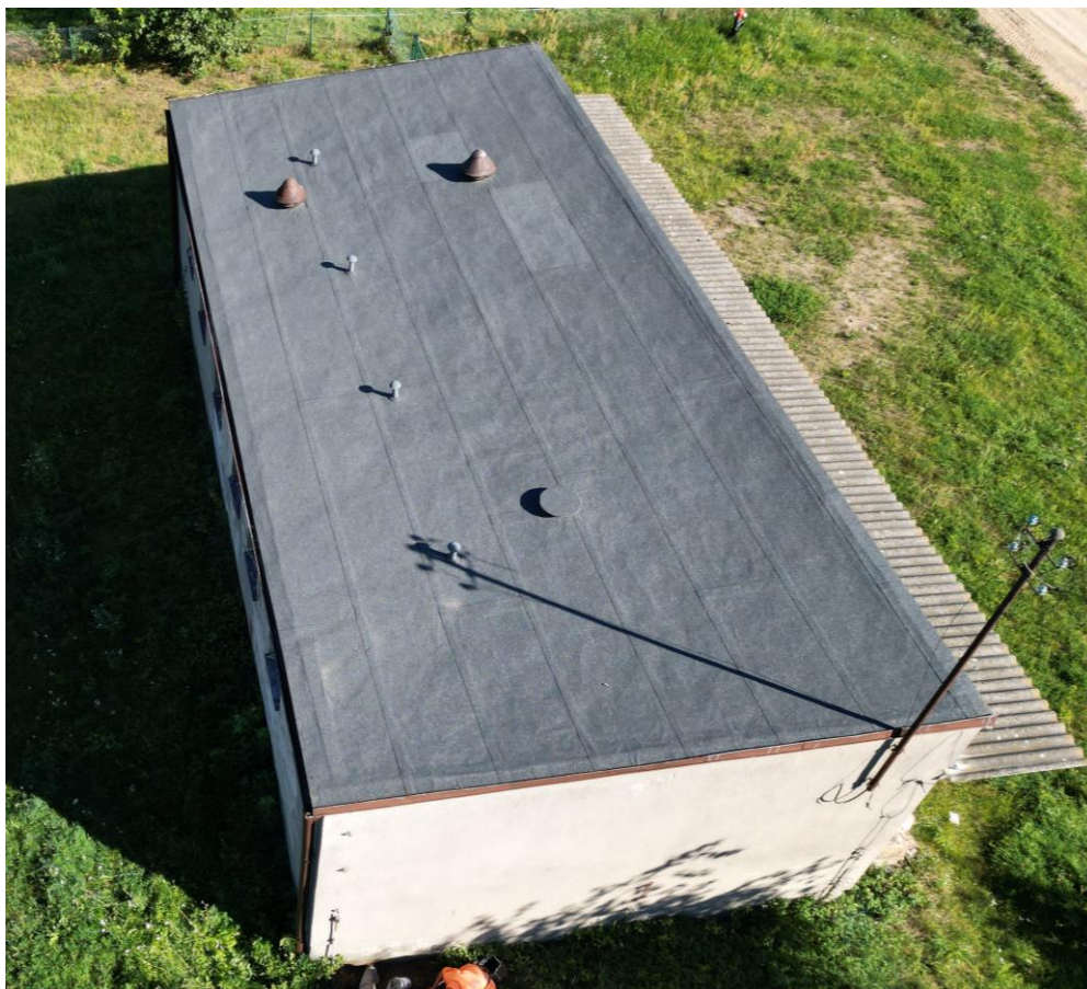
Fot. 7 Widok dachu
