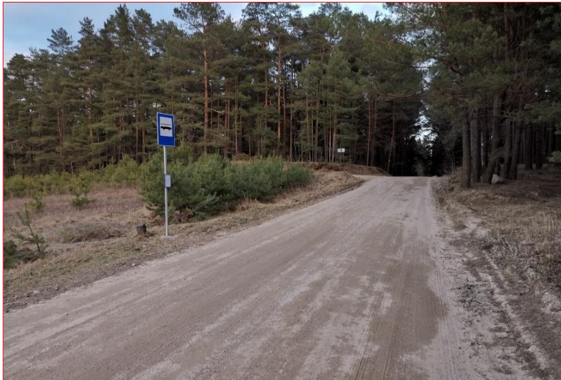
Rysunek 7.6 Infrastruktura punktowa wymagająca modernizacji Źródło: materiały własne
