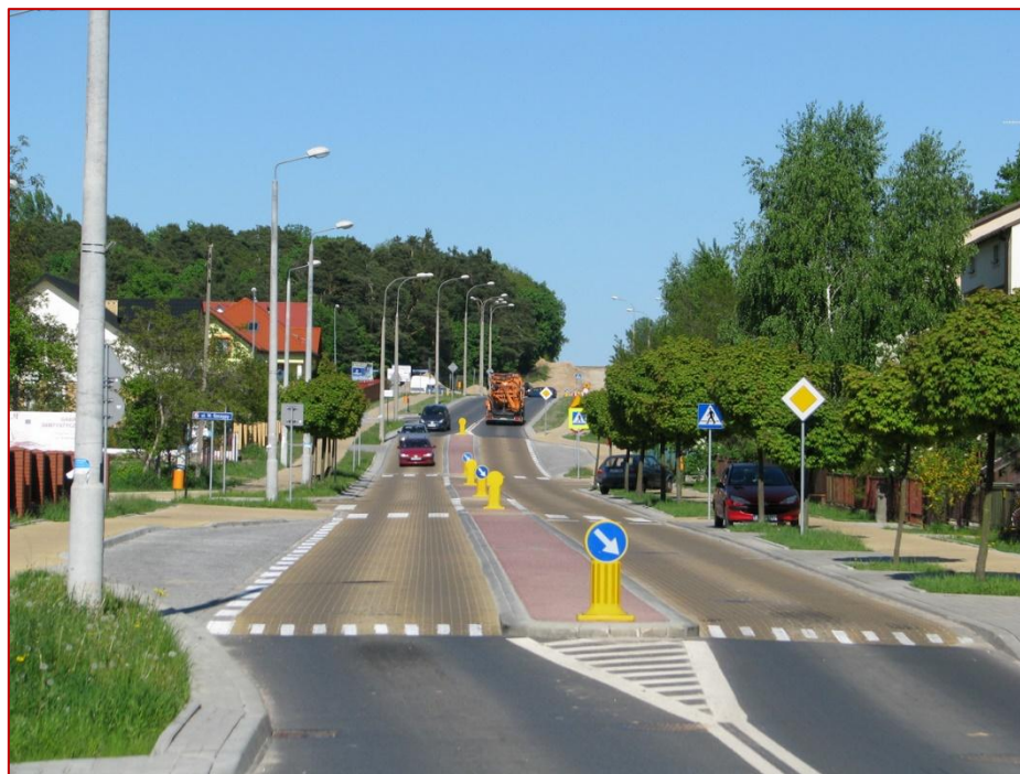
Rysunek 7.19. Ciąg drogi wojewódzkiej z elementami uspokojenia ruchu
