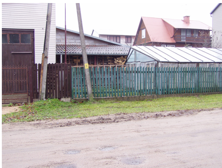
Fot. nr 6. Reper państwowy nr 112903 na cokole ogrodzenia przy działce o numerze geodezyjnym 610. Rzędna 150,39.
