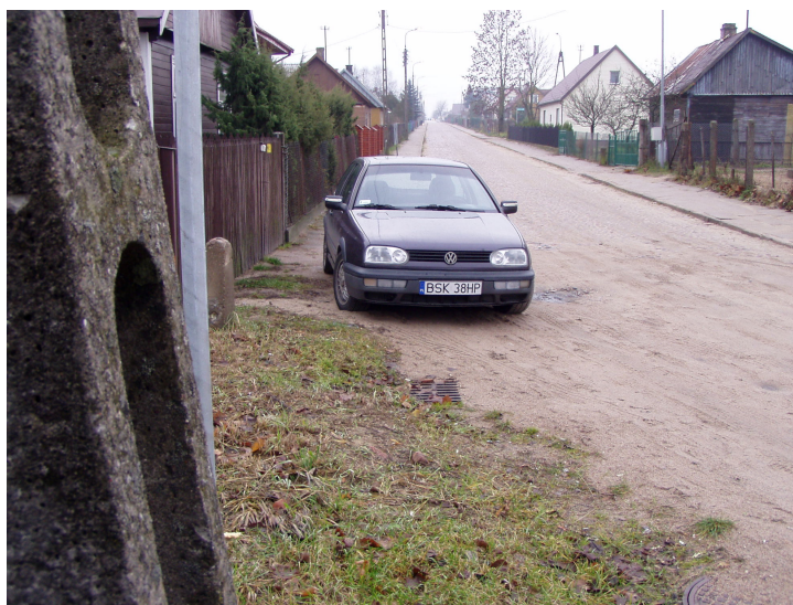
Fot. nr 1. Reper państwowy nr 113007 na cokole ogrodzenia przy budynku nr 22. Rzędna 150,25
