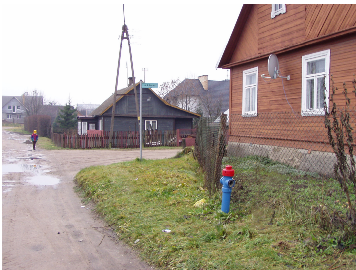
Fot. nr 2. Reper roboczy na hydrancie przy skrzyżowaniu ul. Orzeszkowej z ulicą Dreszera koło budynku nr 15. Rzędna w najwyższym punkcie hydrantu H=150,647.
