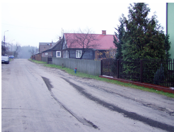
Fot. nr 14. Reper roboczy na hydrancie przy budynku nr 12A. Rzędna w najwyższym punkcie hydrantu H=153,749.
