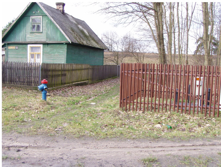
Fot. nr 22. Reper roboczy na hydrancie na końcu ul. Sokólskiej przy przepompowni ścieków. Rzędna w najwyższym punkcie hydrantu H=150,388 .
