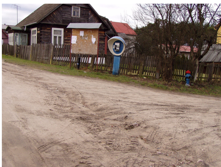
Fot. nr 21. Reper roboczy na hydrancie na skrzyżowaniu ulicy Sokólskiej z ul. Kolejową. Rzędna w najwyższym punkcie hydrantu H=154,741 .
