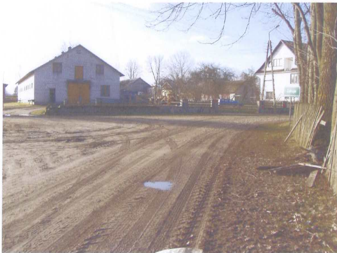
Widok bramy wjazdowej na posesję - na słupku po stronie prawej reper roboczy
