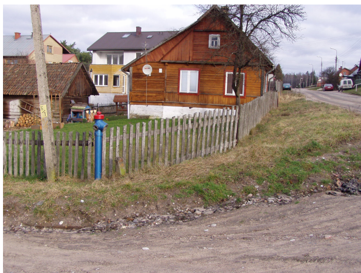
Fot. nr 18. Reper roboczy na hydrancie przy sięgaczu nr 1. Rzędna w najwyższym punkcie hydrantu H=152,684.
