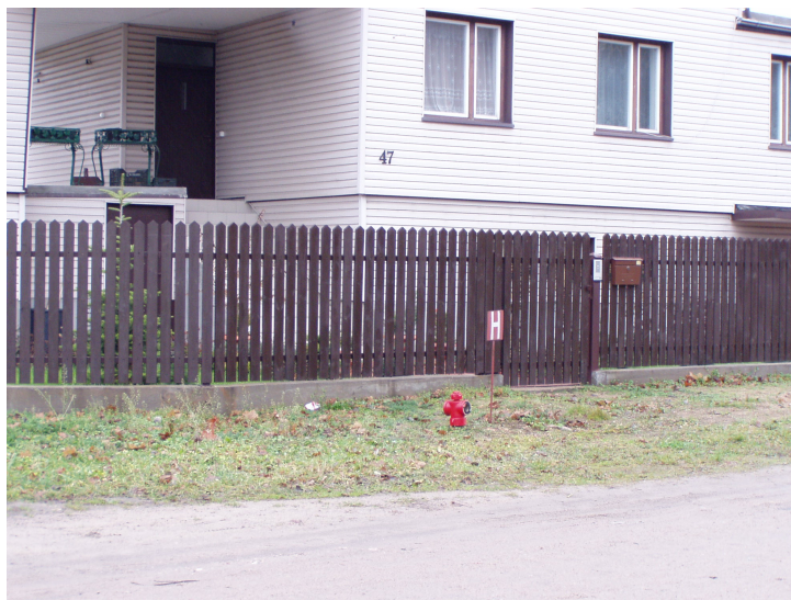
Fot. nr 5. Reper roboczy na hydrancie przy budynku nr 47. Rzędna w najwyższym punkcie hydrantu H=150,458.
