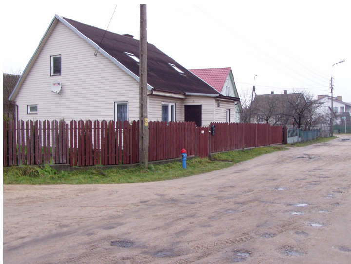
Fot. nr 3. Reper roboczy na hydrancie przy budynku nr 33. Rzędna w najwyższym punkcie hydrantu H=150,620.
