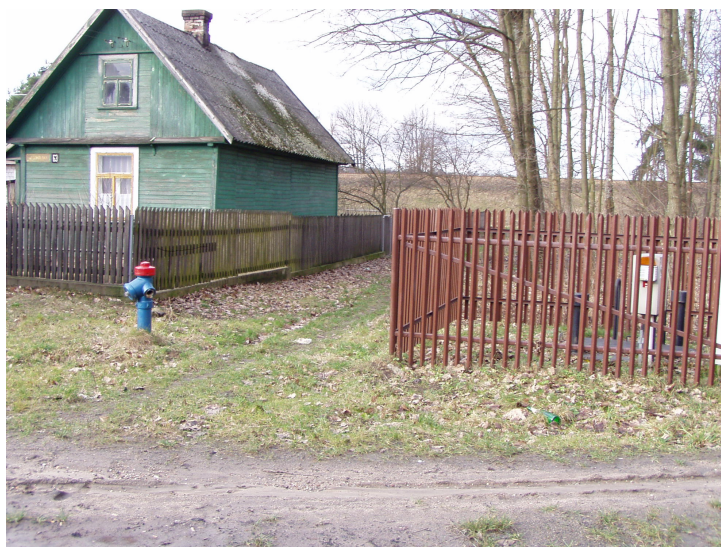
Fot. nr 22. Reper roboczy na hydrancie na końcu ul. Sokólskiej przy przepompowni ścieków. Rzędna w najwyższym punkcie hydrantu H=150,388 .
