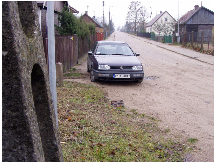
Fot. nr 1. Reper państwowy nr 113007 na cokole ogrodzenia przy budynku nr 22. Rzędna 150,25
